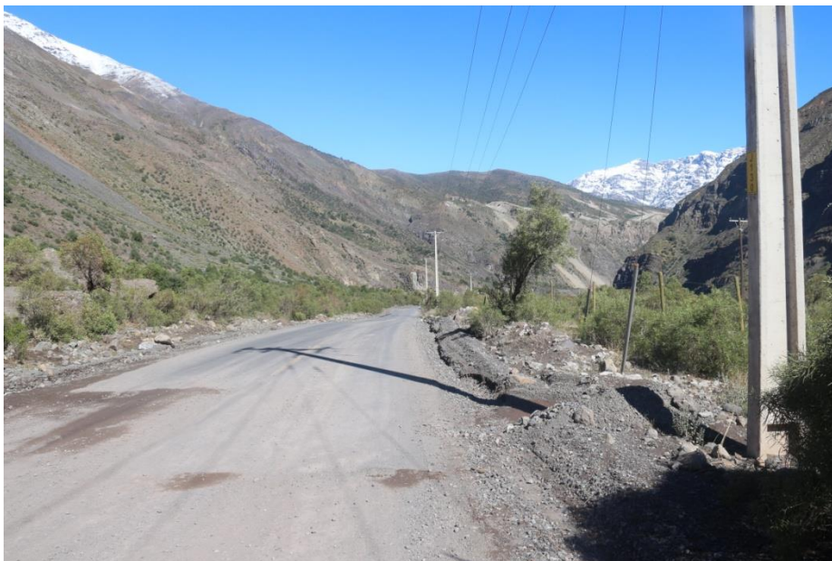
Fotografía 1: Fin de Base granular y carpeta asfáltica en ruta G-455
