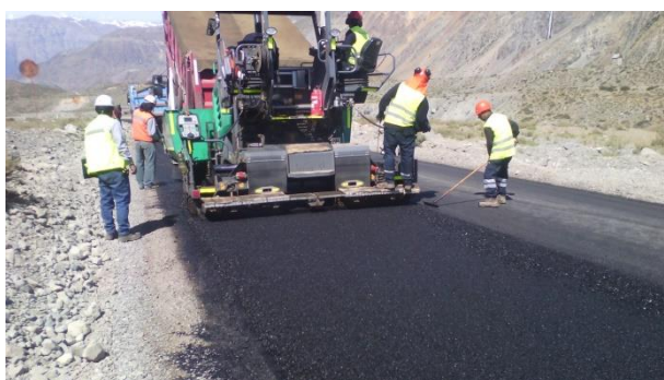
Fotografía N° 1: Colocación capa Asfáltica ruta G-455
