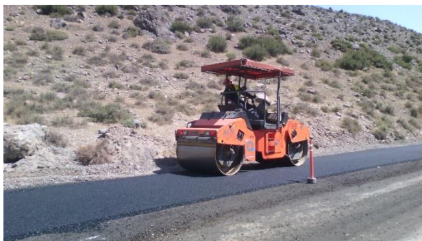
Fotografía 2 Compactación capa asfáltica ruta G-455
