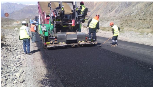
Fotografía 1 Colocación capa Asfáltica ruta G-455
