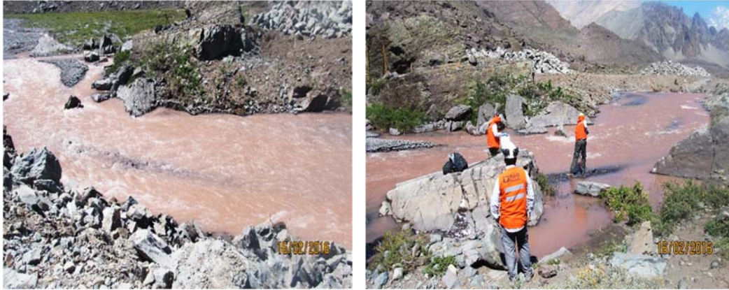
Figura 1.19. Fotografías tomadas en terreno de actividad de muestreo para monitoreo, como parte del plan de seguimiento de aguas superficiales de PHAM, realizado por SGS el día 16.02.2016. (Elaboración propia, 2016)
