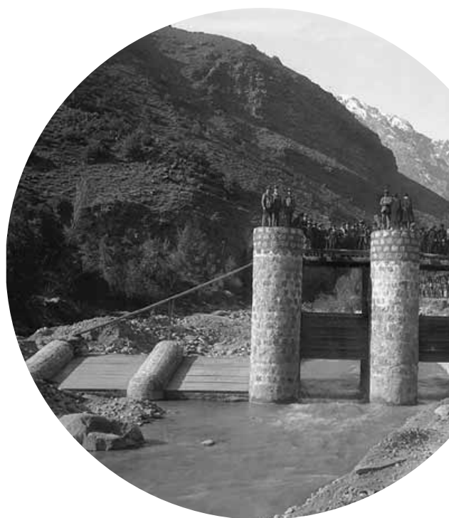
Construcción Central Maitenes, en operación desde 1923
